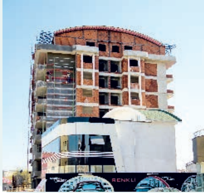
Platin İnşaat / Kuzey Projesi
