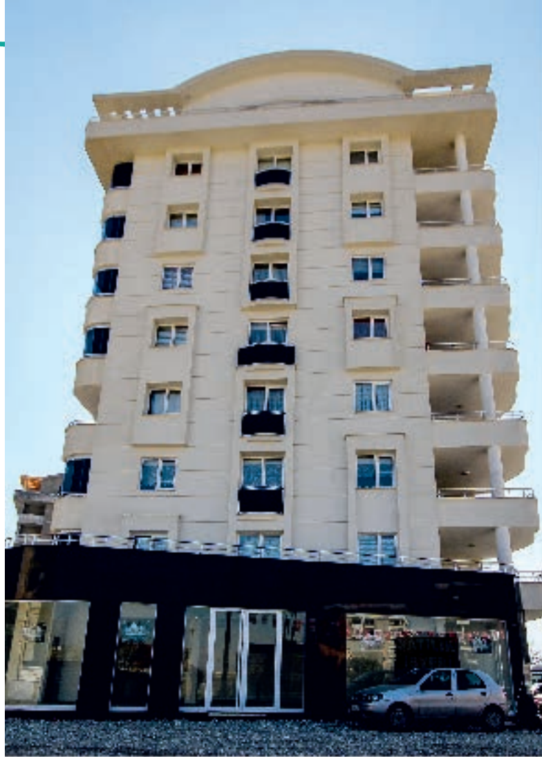
Platin İnşaat / Kuzey Projesi
